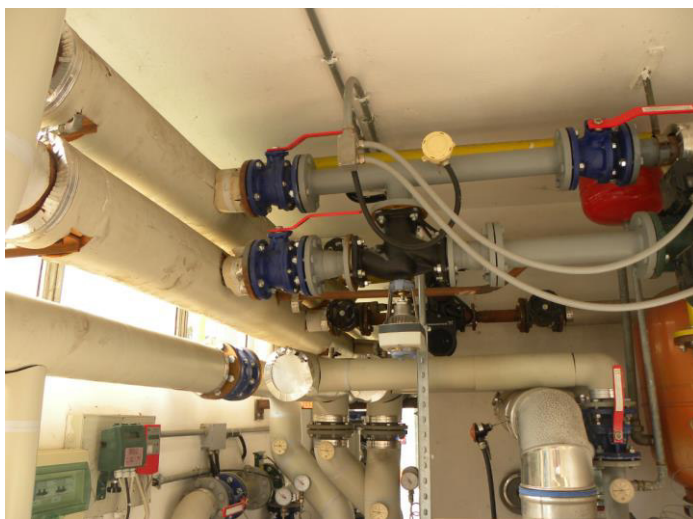
FIGURA 15 SISTEMA DI DISTRIBUZIONE IN CENTRALE TERMICA
