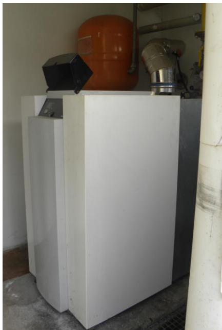
FIGURA 12 CALDAIA A GAS METANO ELCO
